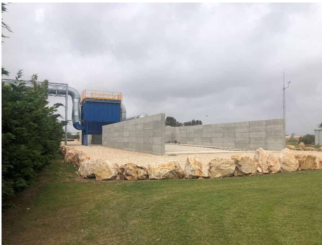
Figura 9: vista biofiltro in fase di realizzazione
