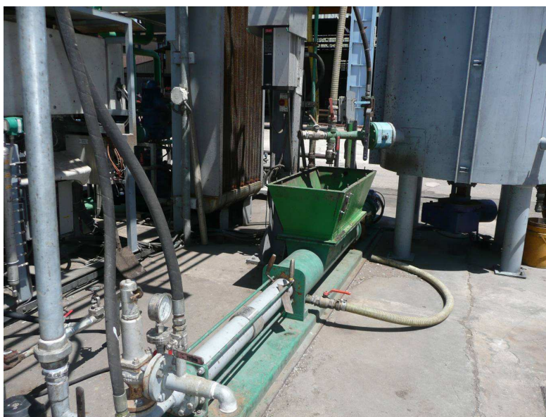
Fig. 41: Pompa Novarotors - vista d'insieme
