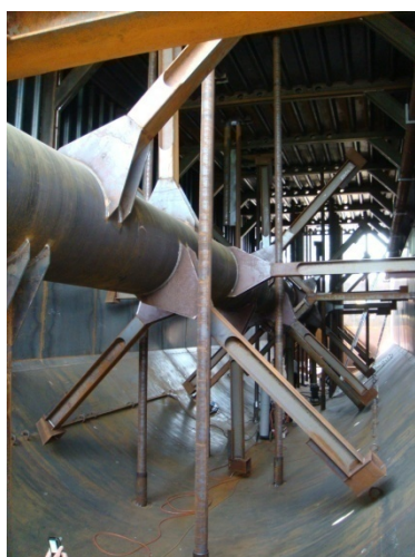
Fig. 21 - Mixer interno al digestore primario
