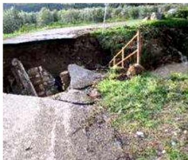
crollo del ponte visto dalla strada
