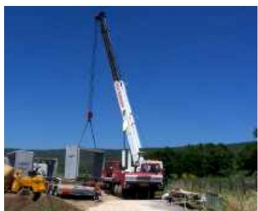
arrivo dei manufatti scatolari in cantiere
