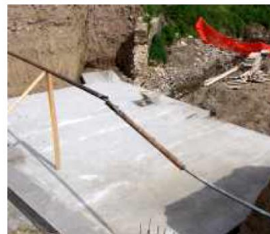
soletta di appoggio dello scatolare
