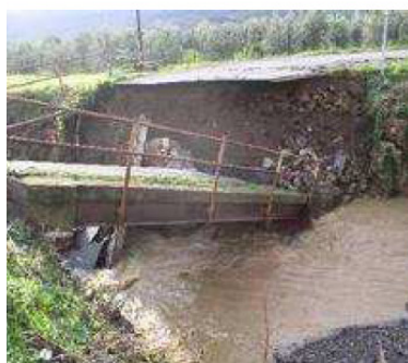
crollo del ponte visto di lato
