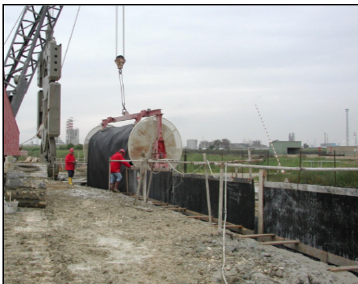
Figura 3.12. Messa in opera del telo HDPE
