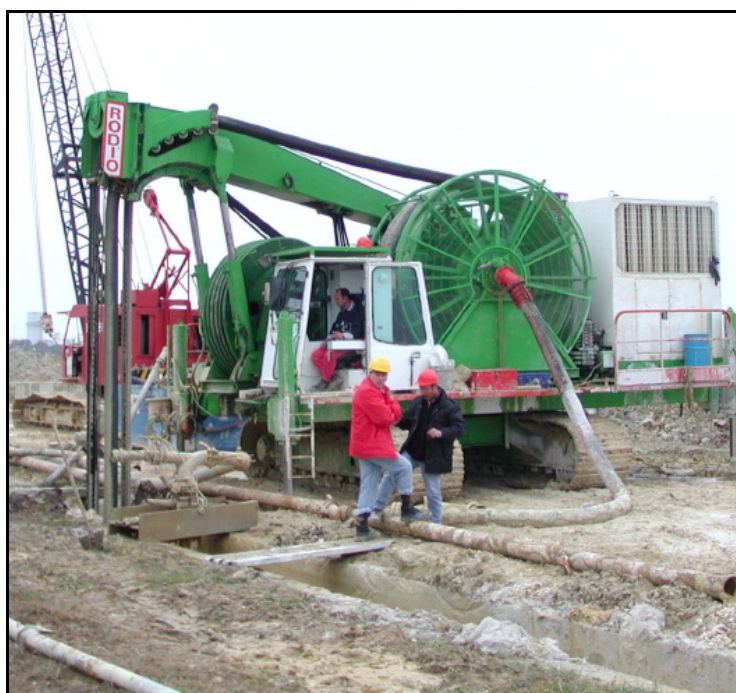
Figura 3.11. Scavo con idrofresa
