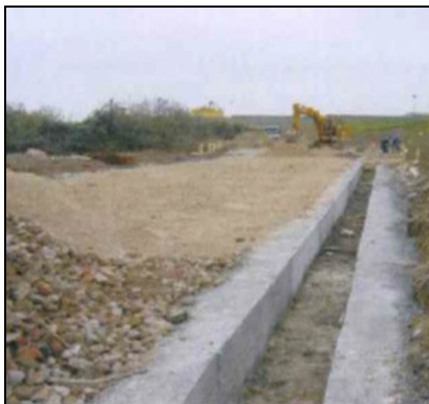
Figura 3.9. Realizzazione delle corree in calcestruzzo
