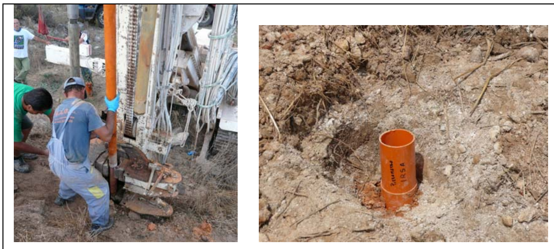
Figura 7. Fotografie relative alle procedure di ultimazione del nuovo piezometro nel sondaggio PZ2 (sinistra) e nuovo piezometro appena realizzato (destra).
